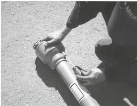
Демонтаж защитного кожуха
